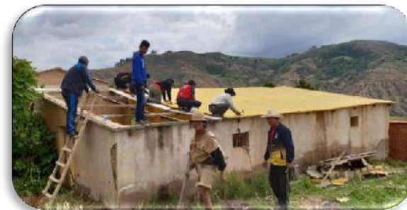
Comunidad Chijmuri. Refacción de la carpa solar para funcionamiento de huerto.
