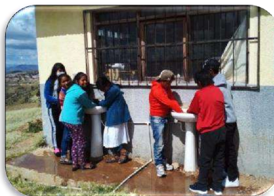
Ciudad de Sucre. Instalación de lavamanos Unidad educativa Tambo Aranjuez
