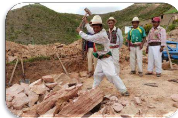
Comunidad Condes. Trabajo comunitario para implementación de 2 aulas
